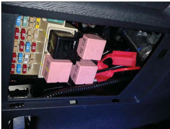
Fig. 2.3. Vista de todo el conjunto de alimentación instalado.
