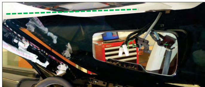
Recorrido del cable del módulo tarifario
