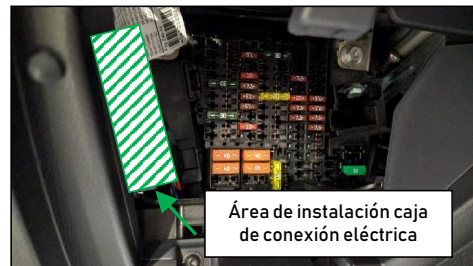
Figura 4. Área de instalación caja conexión eléctrica.
