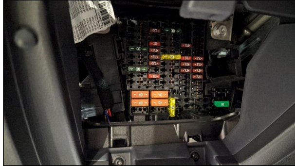
Figura 2. Caja de fusibles.
