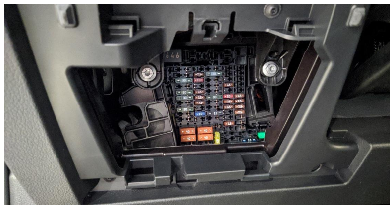
Figura 2. Caja de fusibles.
