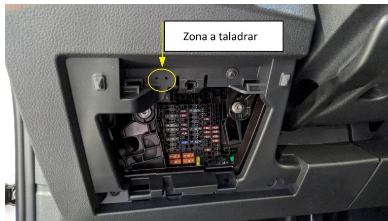
Figura 5. Zona a taladrar en el área de la caja de fusibles.
