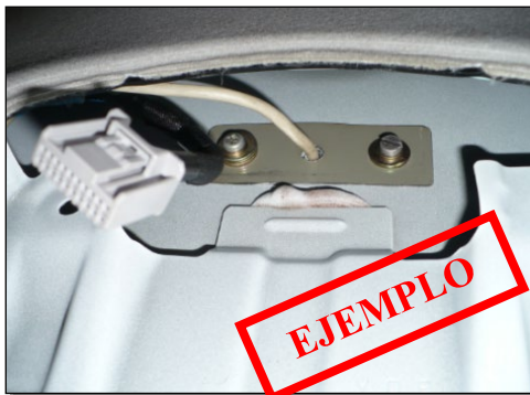
Detalle del hueco de luces de techo y pletina con tornillos y cable de la capilla
