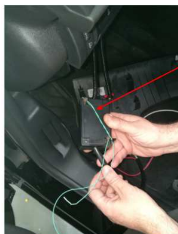
Precintado caja adaptadora de señal
