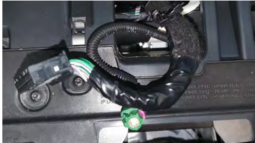
Fig. 2.3. Detalle conexión cable y manguera blindada al conector 247
