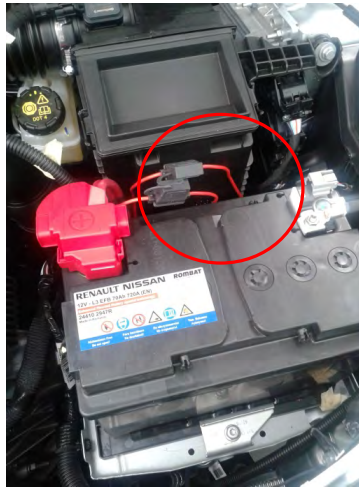
Fig. 2.1. Vista del fusible exterior
