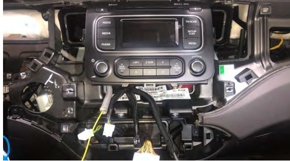
Fig. 1.6. Detalle del paso de manguera blindada al habitáculo en la consola central.
