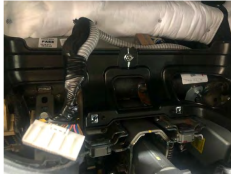
Fig. 1.5. Detalle del montaje final de la toma de señal y paso de manguera blindada por detrás del cuadro.
