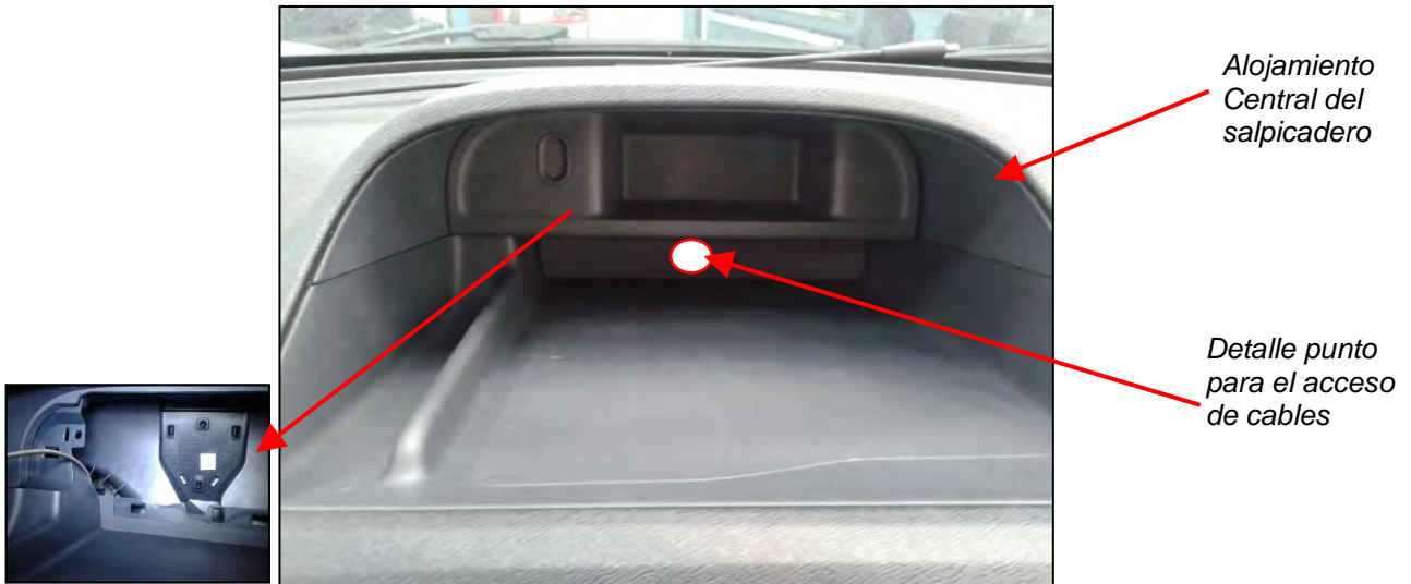
Fig. 2.3. Vista de la ubicación de la caja de conexiones.
