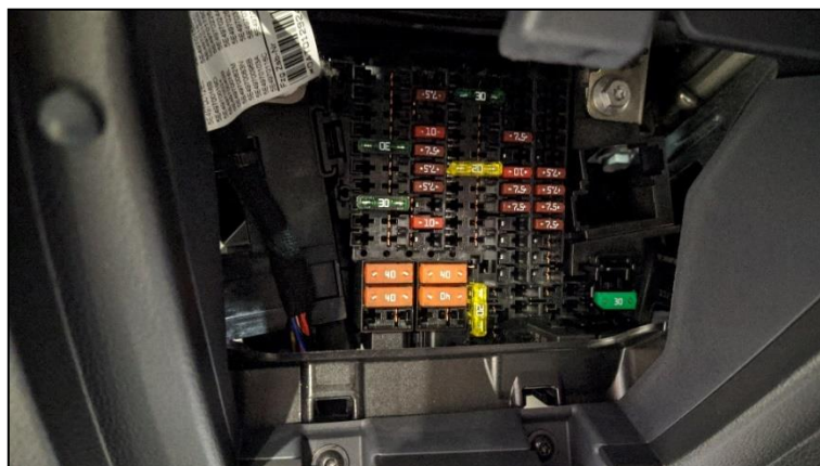
Figura 2. Caja de fusibles.
