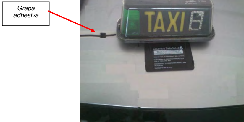
Fig. 6.4. Recorrido cable por el techo
