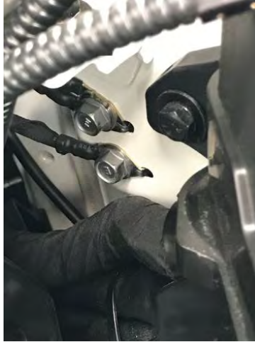
Fig. 2.2. Vista de las conexiones de alimentación.
