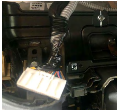
Fig. 1.4. Detalle del montaje final de la toma de señal y paso de manguera blindada por detrás del cuadro.
