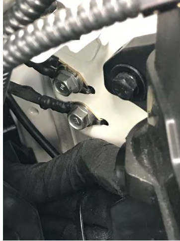
Fig. 2.2. Vista de las conexiones de alimentación.
