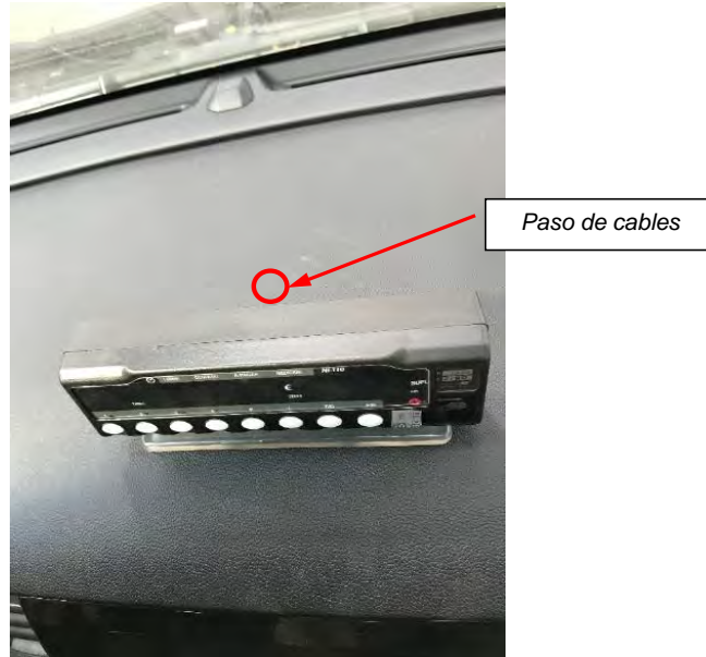
Fig. 4.5. Paso de cables para tax3metro de consola
