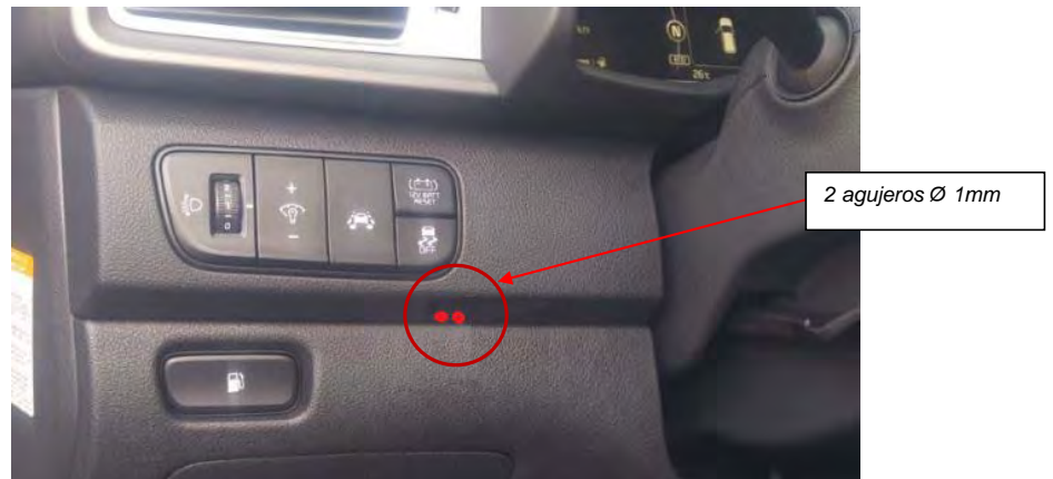
Fig. 1.9. Perforado del salpicadero para paso del alambre.
