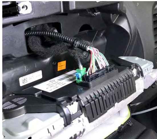
Fig. 2.1.2. Vista del conector 247 con el cuadro desmontado
