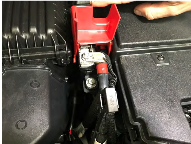
Fig 2.2. Imagen del conector de alimentación sobre la conexión al borne positivo y del fusible
