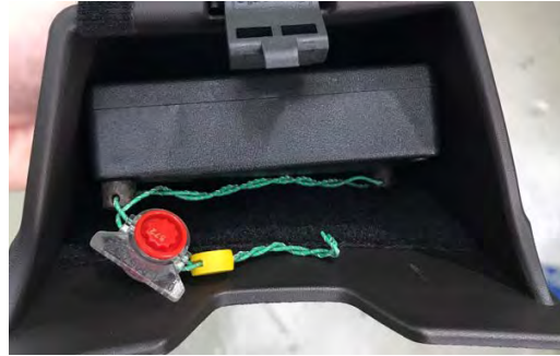
Fig 3.3. Imagen de la caja de conexiones precintada.
