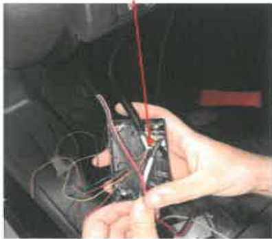
Conexiones caja adaptadora de señal
