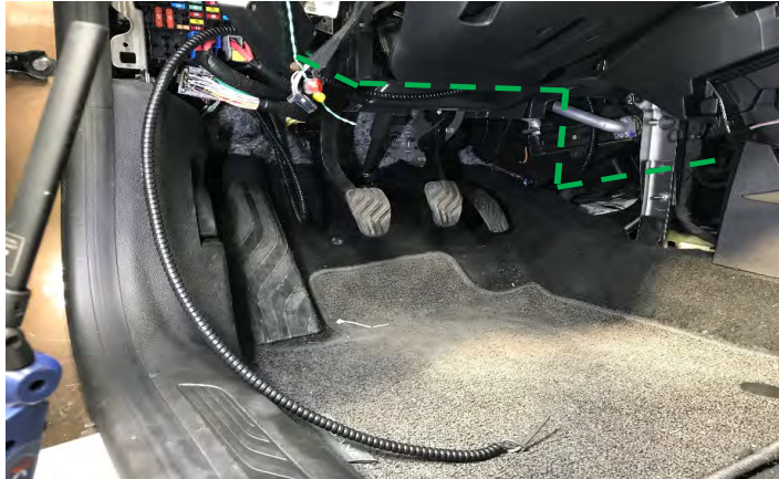
Fig. 2.5. Detalle recorrido del cable por el interior del guarnecido bajo el salpicadero hasta el compartimento de la caja de fusibles
