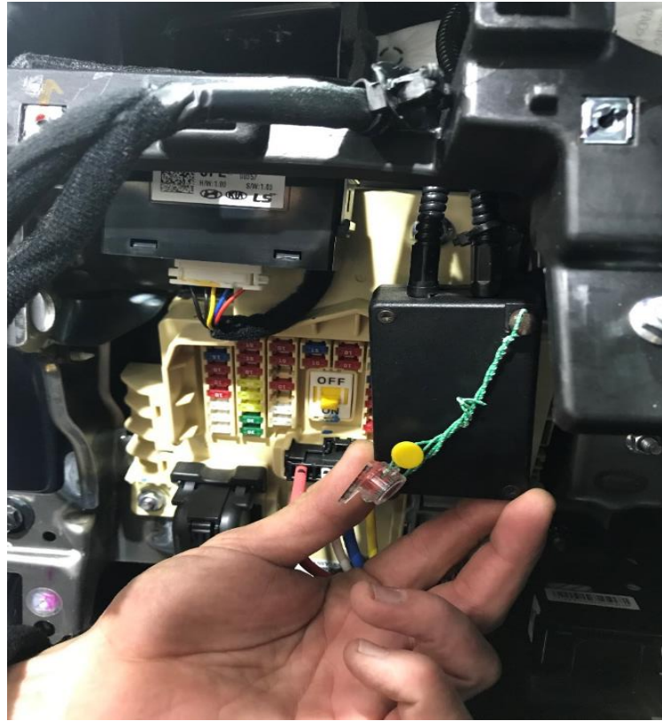
Fig. 3.4. Vista del emplazamiento de la caja de conexiones y de su precinto
