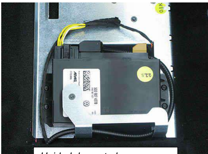
Unidad de control y manguera blindada montadas
