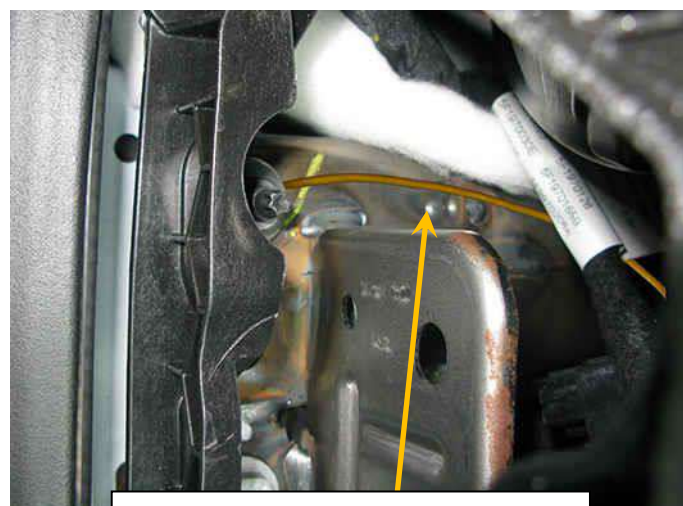
Cable de masa instalado
