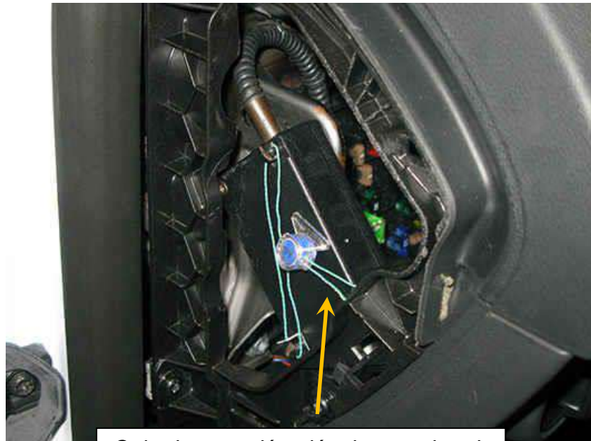
Caja de conexión eléctrica precintada
