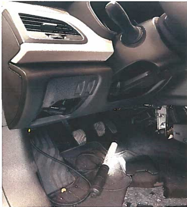
Fig. 3.1. Vista de la terminación de la manguera blindada puesta por el concesionario
