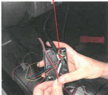
Conexiones caja adaptadora de señal
