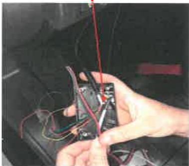
Conexiones caja adaptadora de señal
