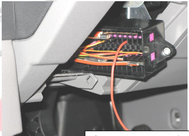
Cable de alimentación
