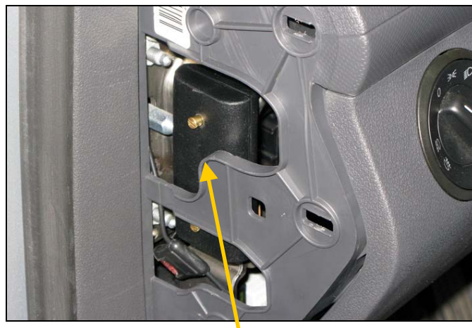
caja conexión eléctrica
