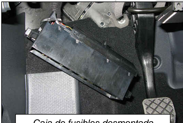
Caja de fusibles desmontada
