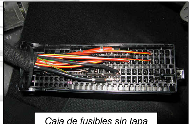
Caja de fusibles sin tapa
