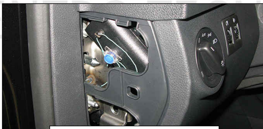
Precinto caja de conexión eléctrica
