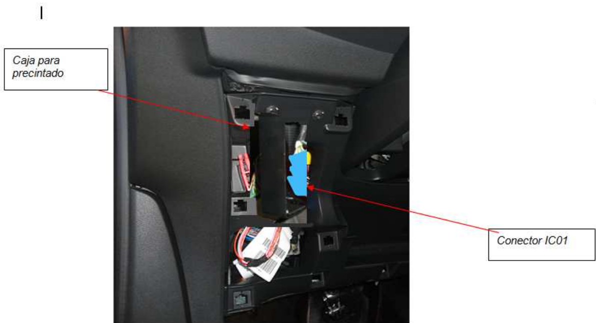
Fig. 3.2. Insertar el conector IC01B en el interior de la caja de plástico
