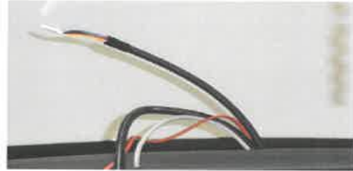
Mangueras pasadas por el taladro del salpicadero.
